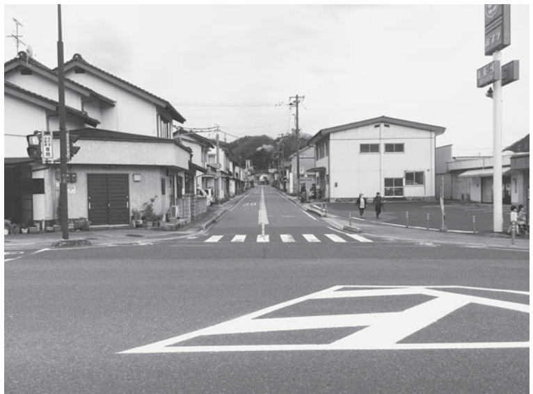
改良が必要な上川戸粕淵線
