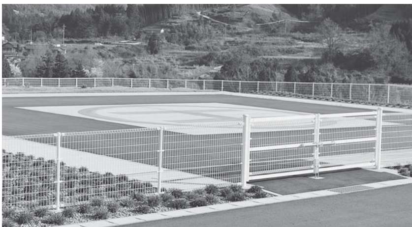
防災公園にあるヘリポート
