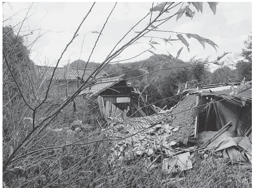
放置された空き家
